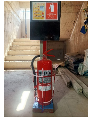
รูปที่ 52 ถังดับเพลิงพร้อมป้ายวิธีใช้งาน
