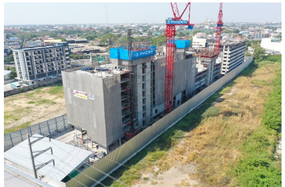
รูปที่ 11 ผ้าใบก่อสร้าง (Mesh sheet) ล้อมรอบอาคาร
