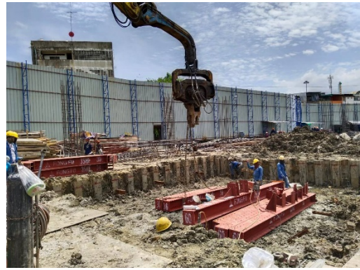
รูปที่ 6 ติดตั้ง Sheet Pile
