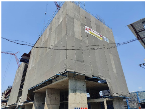
รูปที่ 11 ผ้าใบก่อสร้าง (Mesh sheet) ล้อมรอบอาคาร
