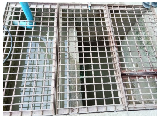
รูปที่ 35 รางระบายน้ำและบ่อดักขยะ
