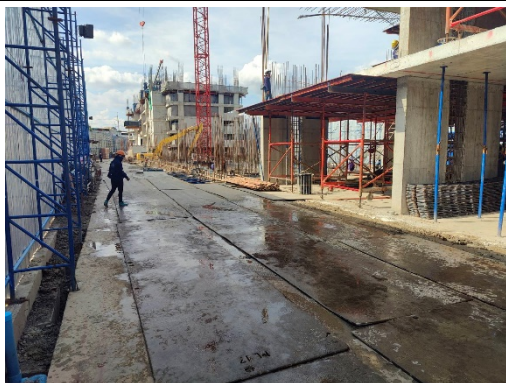
รูปที่ 22 แผ่นเหล็กปูล้อมรอบโครงการ
