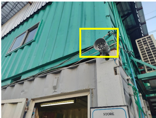
รูปที่ 53 อุปกรณ์เตือนภัยแจ้งเหตุฉุกเฉิน
